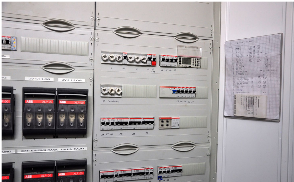
Abb. 4 Stromkreisskizzenzeichnung und zugehörige Dokumentationen einer elektrischen Unterverteilung
