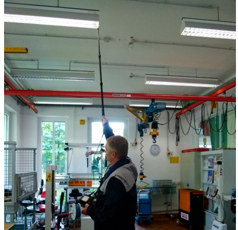
Abb. 9 Messung der niederohmigen Schutzleiterverbindung; Leuchte
